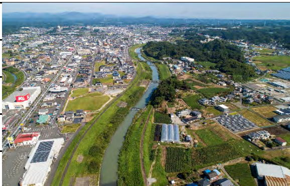
【小川端橋から加茂橋 (R3/9月)】
