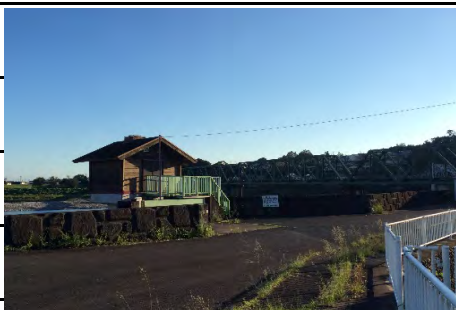
鹿島ひ管付近
