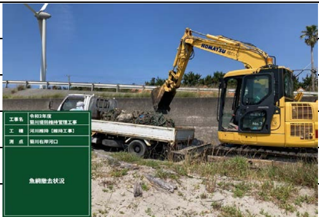
工事名 令和2年度 菊川堤防維持管理工事 工種 河川維持（維持工事） 測点 菊川右岸河口 魚網撤去状況
