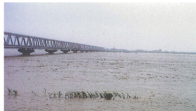
東海道新幹線橋梁付近の出水状況
