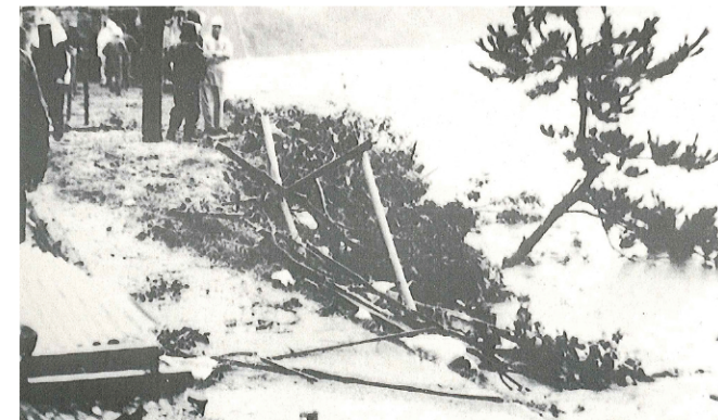
「木流し工」実施状況(磐田市上野部)
