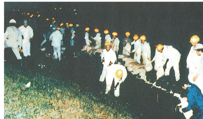
夜間での「月の輪工」実施状況(浜松市南区三新町)
