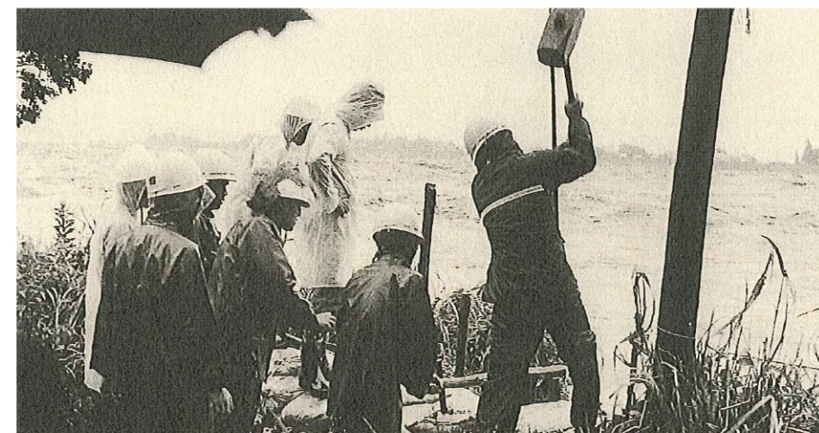
「積み土のう工」実施状況(磐田市上野部)
