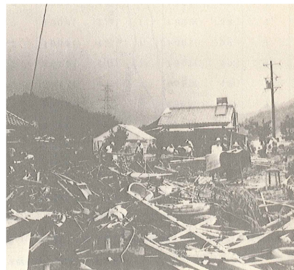
二俣川沿川の被害状況(浜松市天竜区二俣町)
