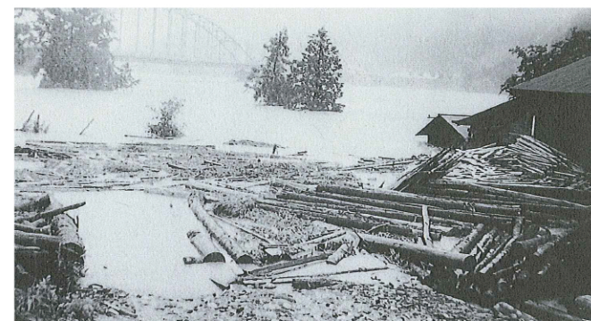
中部大橋上流の浸水状況(浜松市天竜区佐久間町)
