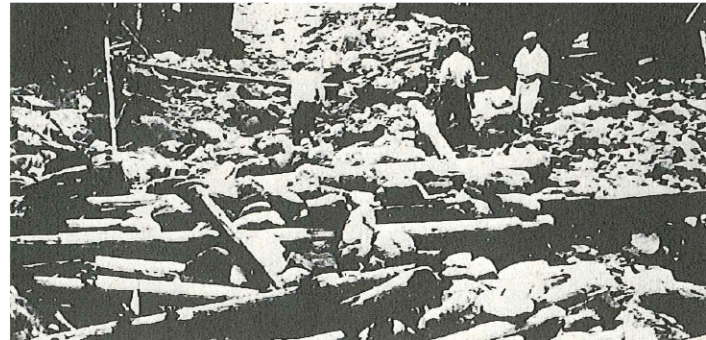
支川翁川のはん濫により流出した家屋(浜松市天竜区水窪町)
