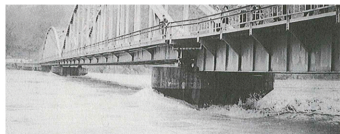
中部大橋付近の出水状況(浜松市天竜区佐久間町)
