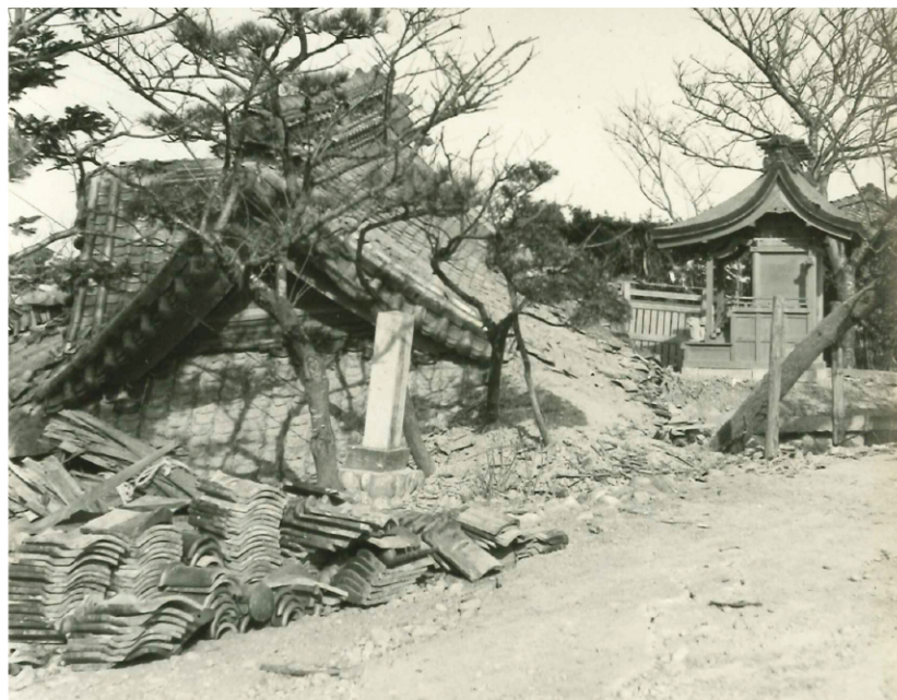
倒壊した六所神社(浜松市東区中野町)
