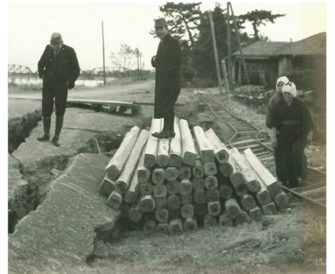
堤防被害の調査(12月20日 浜松市東区)
