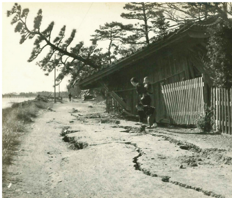
堤防に発生した亀裂(浜松市東区中野町)
