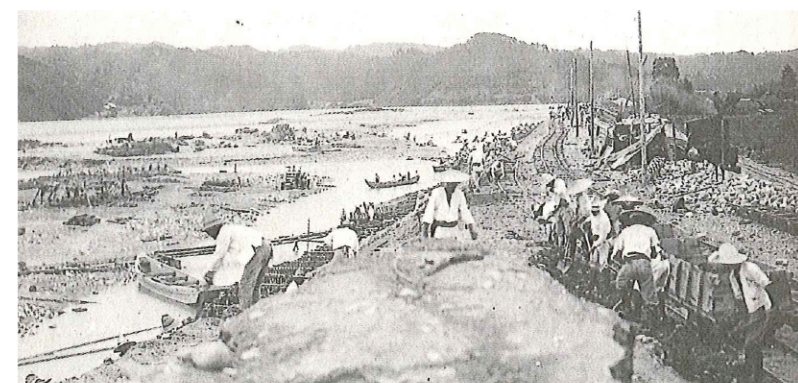
中瀬地先の締切工事
