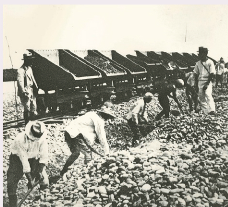
築堤工事風景(昭和7年頃)
