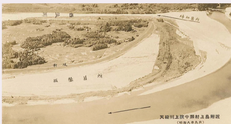
浜松市浜北区上島地先(昭和8年9月)
