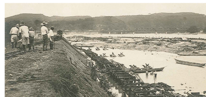
護岸立枠及び猪子布設
