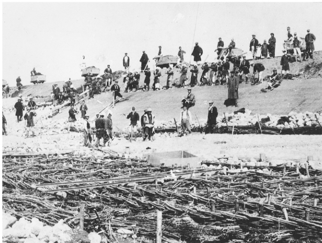
護岸（そだ沈床）施工状況（明治44年頃 磐田市一貫地地先）
