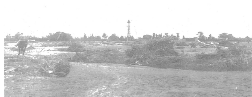
天竜川西派川堤防決壊直後の農地の流出状況(浜松市南区金折町)
