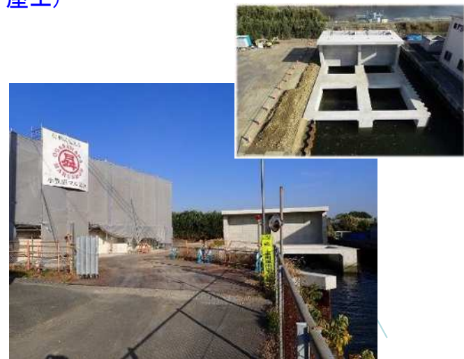
■高塚川排水機場の新設(機械・電気設備、建屋工)
