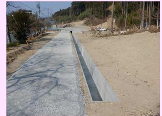
治山工事(流路工・沈砂池工)
