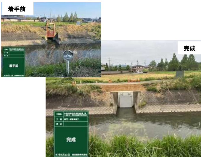
■フラップゲート設置(馬込川支川排水路)
