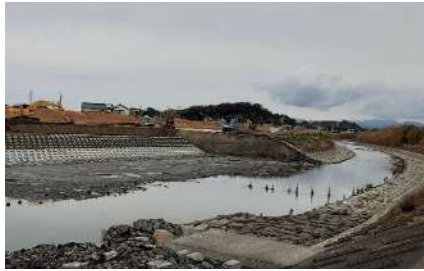
菊川の河道掘削(大石地区)
