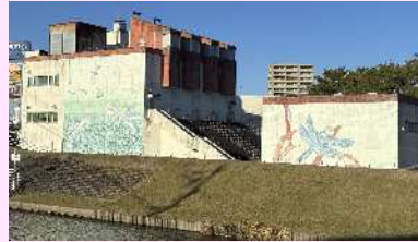
今之浦第2ポンプ場
