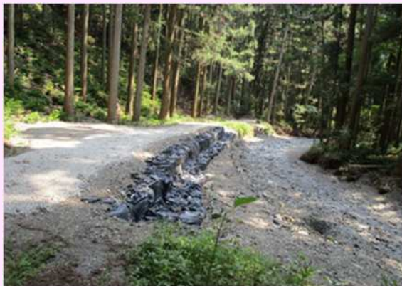
林道神田線の整備(擁壁工)
