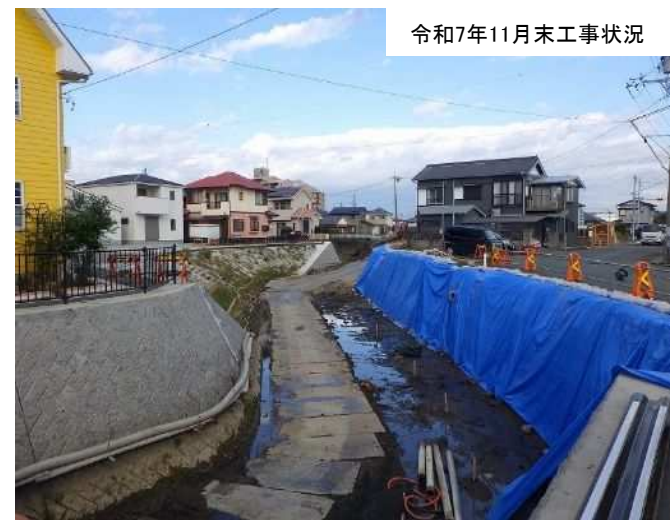
■河川改修(準用河川東芳川、護岸工)
