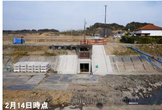
佐東川にて、千手樋門の無動力化を実施 (R8.3末完成見込み)
