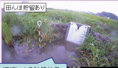
堰板による貯留効果を確認
