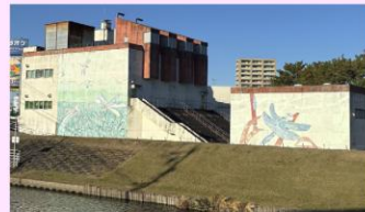
今之浦第2ポンプ場
