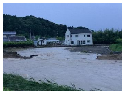
二級河川敷地川の破堤 (磐田市敷地)
