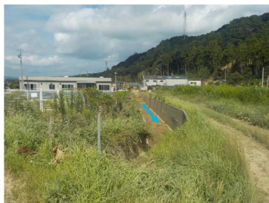
流域内の排水路の状況（土砂が堆積している）
