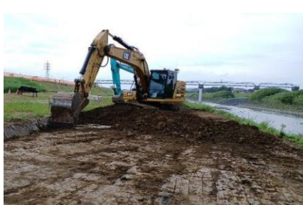
菊川の河道掘削(大石地区)
