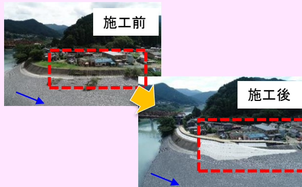
堤防整備(谷山地区)
