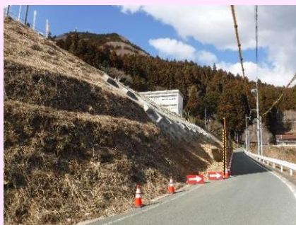
急傾斜地崩壊防止施設の設置
