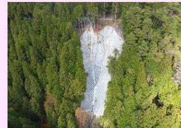
治山工事(山腹工)
