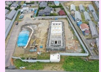
【磐田市】大島排水ポンプ場 (建築工事)
