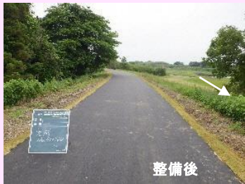
【県】太田川 堤防舗装工 (袋井市中)
