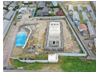
大島排水ポンプ場(建築工事)
