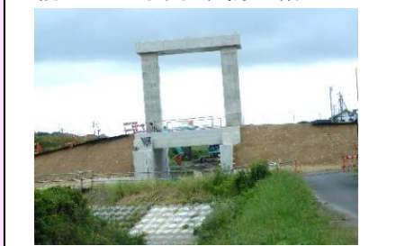
下前田川の水門・堤防整備
