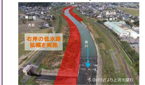
R4河道掘削(5.0k付近)
