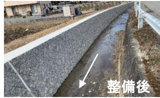
油山川(護岸工)
