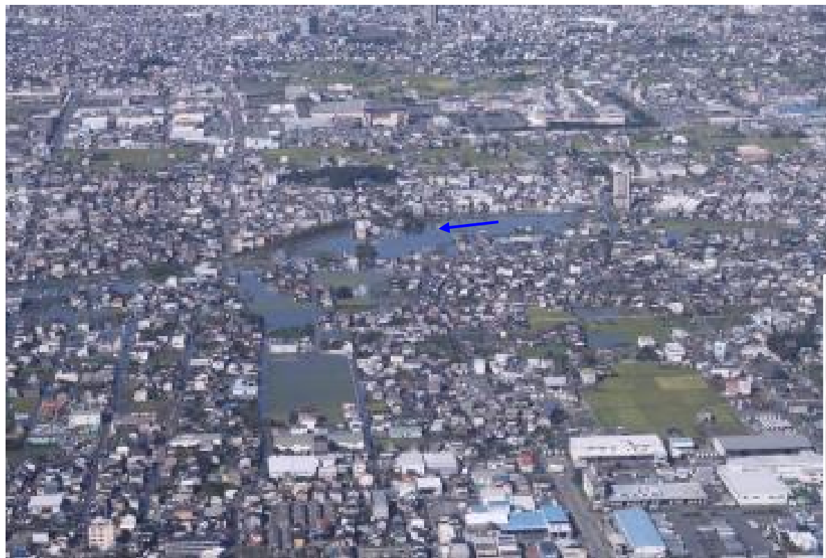
台風第15号 浜松市東区 安間川付近
