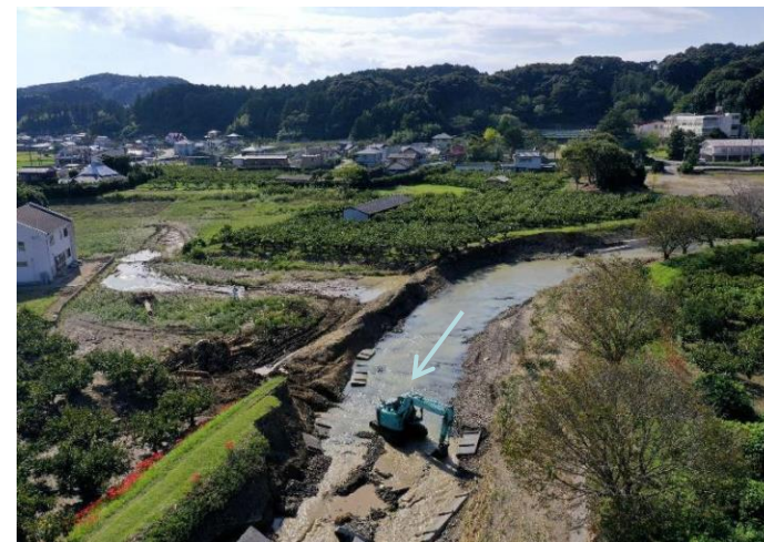
二級河川敷地川 磐田市敷地
