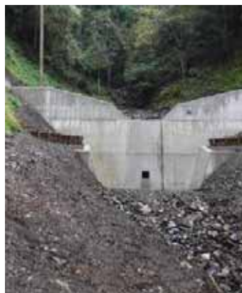
北設楽郡東栄町 地内 渓流の勾配を緩和 下流域への土砂流出を抑止
