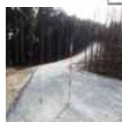
【森林整備：林道 (整備)】
