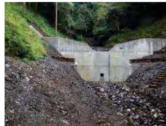
北設楽郡東栄町 地内 溪流の勾配を緩和 下流域への土砂流出を抑止
