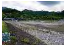
河道掘削(静岡県)
