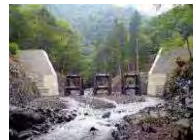
【治山:溪間工(スリットダム)】
