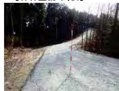
【森林整備:林道(整備)】
