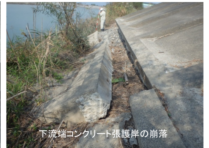
低水護岸の崩落(H27被災)
