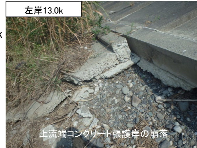
低水護岸の崩落(H27被災)
