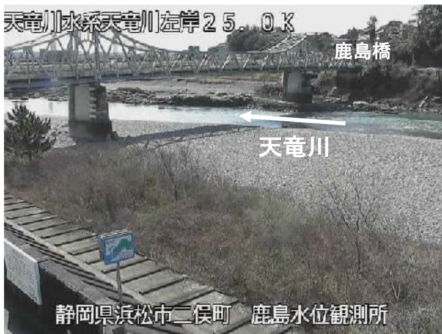
天竜川 鹿島観測所の状況(平常時)
