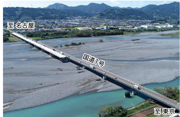
■島田金谷バイパス(新大井川橋)
