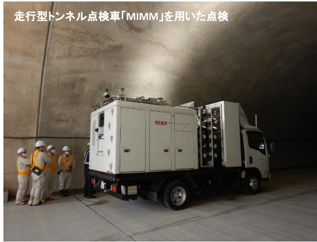
トンネル点検の状況（三遠道路1号トンネル）
