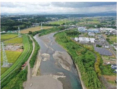
河道掘削 (静岡県等)
