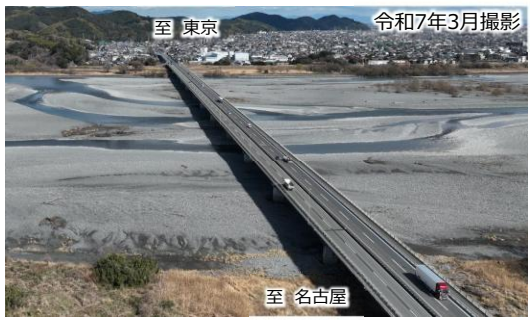
②新大井川橋 (右岸側)
