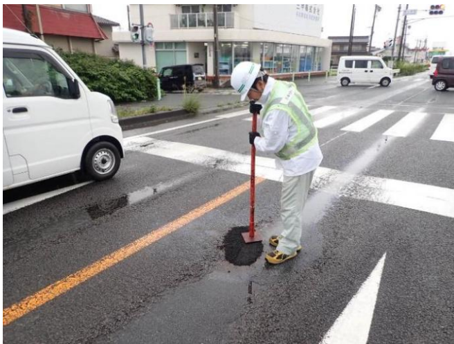
舗装の応急復旧の状況
