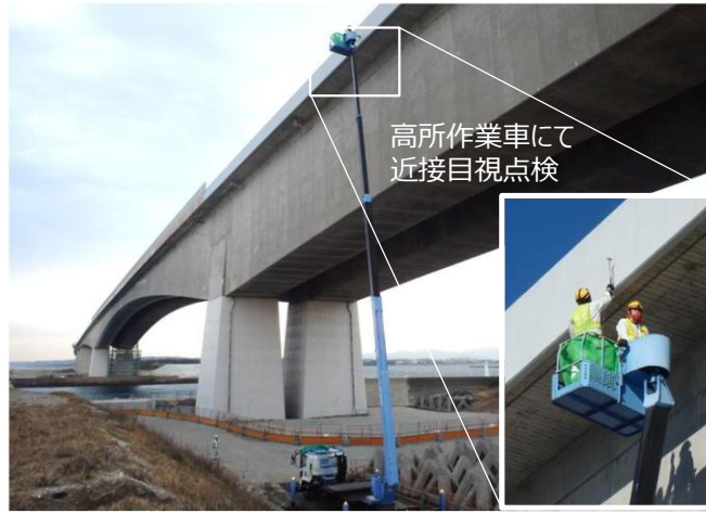
橋梁点検の状況（浜名大橋）
