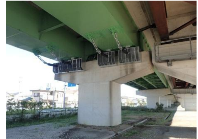
橋梁耐震補強の状況（袋井高架橋）
