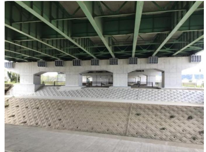
橋梁耐震補強の状況（土橋高架橋）
