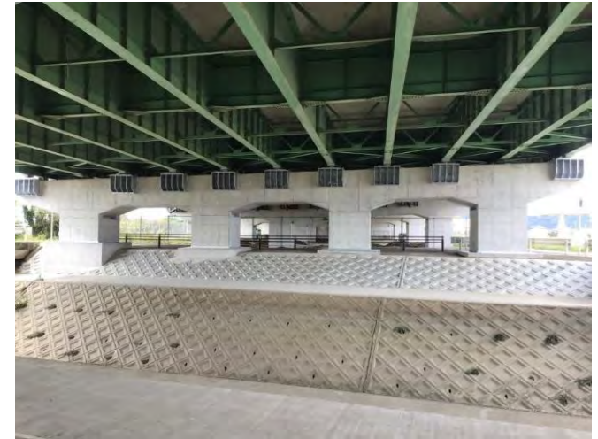
橋梁耐震補強の状況（つちばし高架橋）
