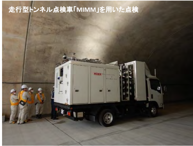
トンネル点検の状況（三遠道路1号トンネル）
