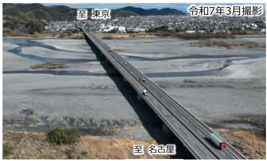
②新大井川橋 (右岸側)
