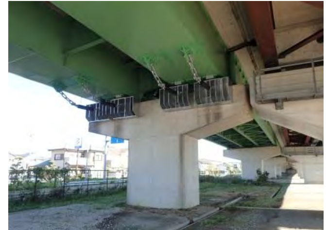
橋梁耐震補強の状況（袋井高架橋）
