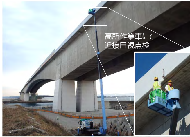
橋梁点検の状況（浜名大橋）
