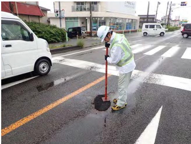
舗装の応急復旧の状況
