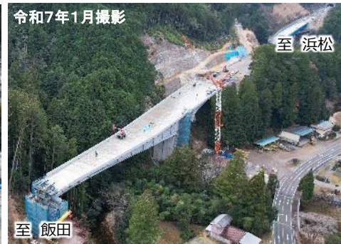
②・③ 8号橋（上部工架設中）
