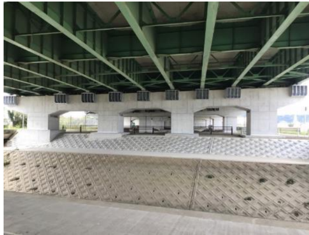
橋梁耐震補強の状況（土橋高架橋）
