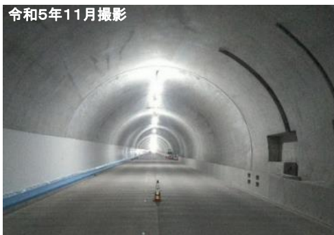
① 3号トンネル
