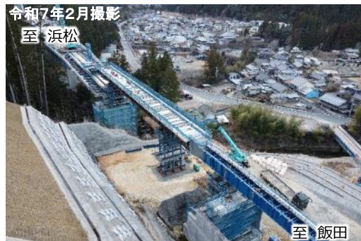
②・③ 8号橋（上部工架設中）
