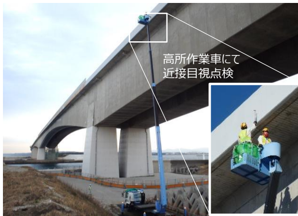
橋梁点検の状況（浜名大橋）
