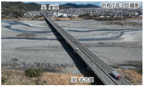
②新大井川橋（右岸側）
