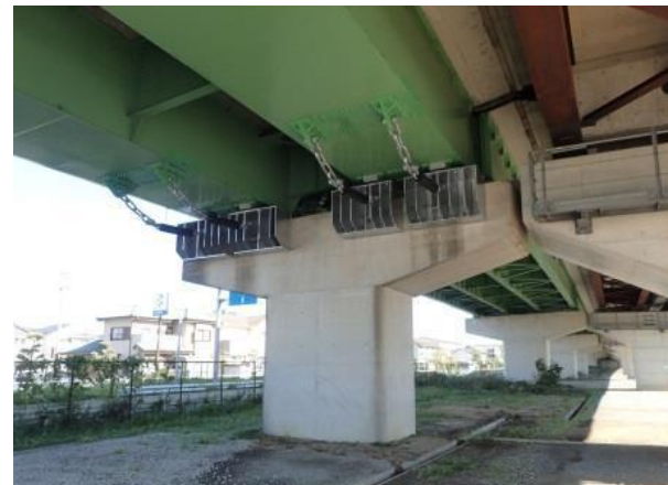
橋梁耐震補強の状況（袋井高架橋）
