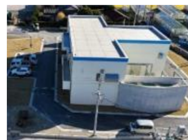
ポンプ場の整備（磐田市等）
