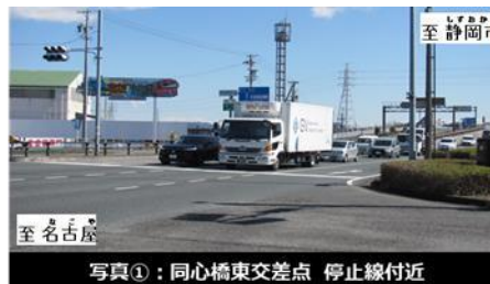
写真①：同心橋東交差点 停止線付近
