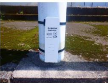
浸水センサの設置（浜松市等）
