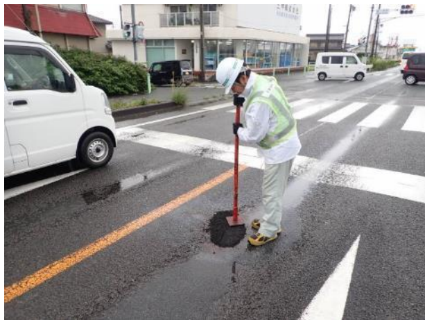
舗装の応急復旧の状況
