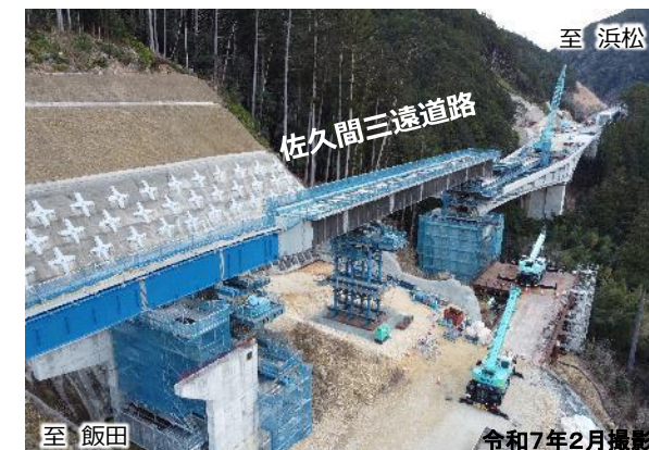
①三遠道路の施工状況（8号橋）
