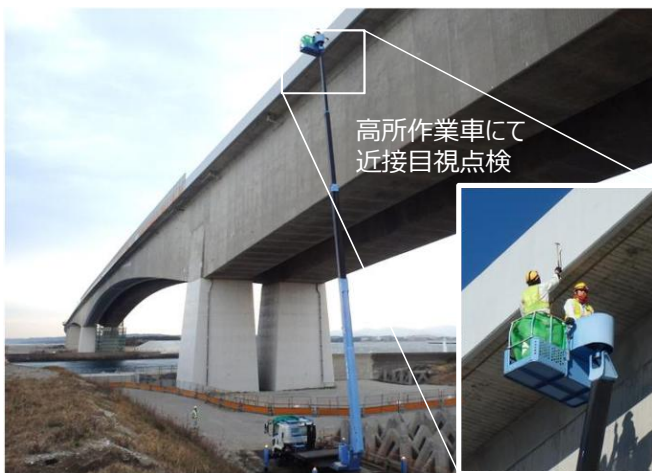
橋梁点検の状況（浜名大橋）
