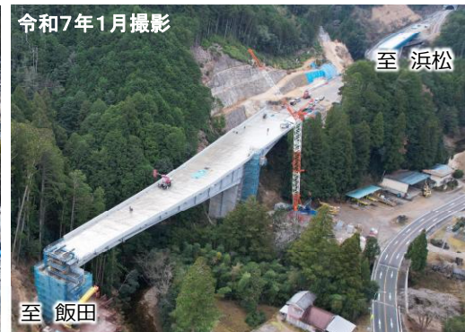
②・③ 8号橋（上部工架設中）
