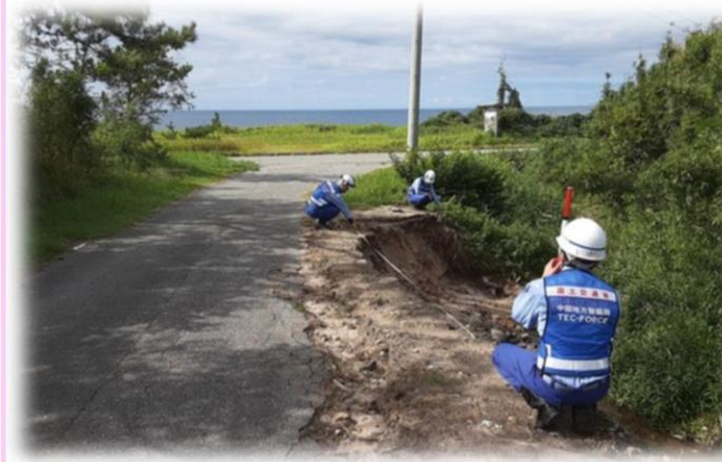
豪雨による道路被災状況
