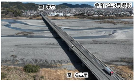
②新大井川橋（右岸側）
