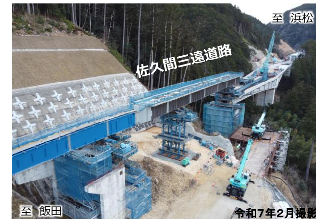
①三遠道路の施工状況（8号橋）
