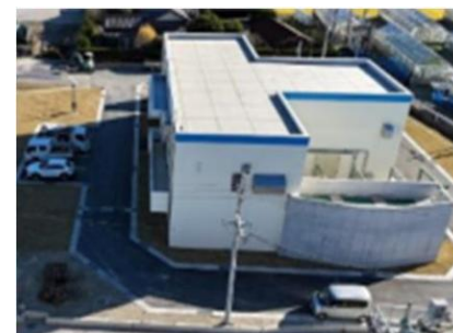
ポンプ場の整備（磐田市等）
