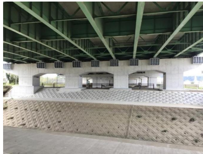
橋梁耐震補強の状況（ つちおか 土橋高架橋）
