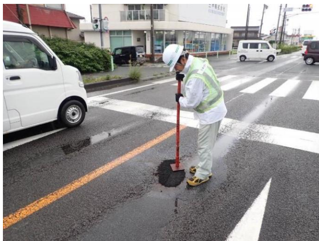
舗装の応急復旧の状況
