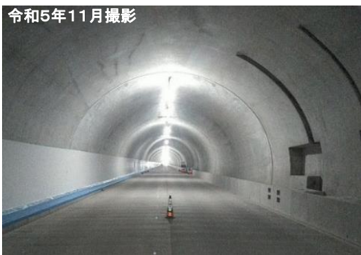
① 3号トンネル
