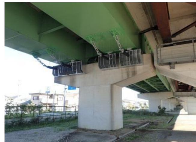
橋梁耐震補強の状況（袋井高架橋）
