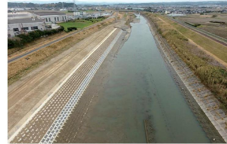
菊川における河道掘削および堤防補強(令和4年度完成)
