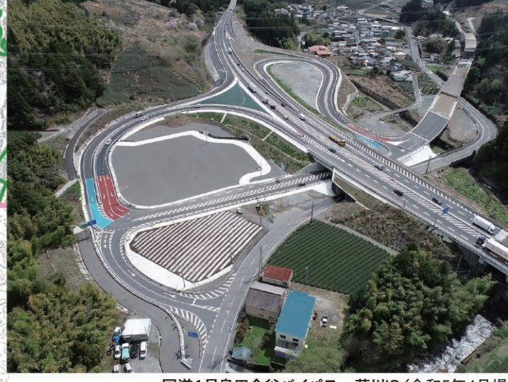
国道1号島田金谷バイパス 菊川IC (令和5年4月撮影)
