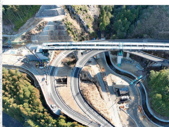
三遠南信自動車道 風来峡IC (令和6年1月撮影)
