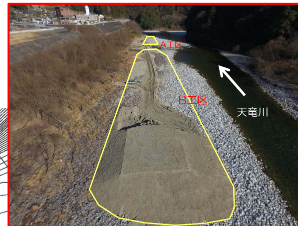
施工状況 H29.1.20
