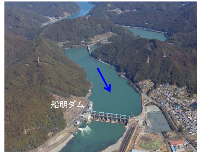
船明ダム (土砂堆積が懸念)
