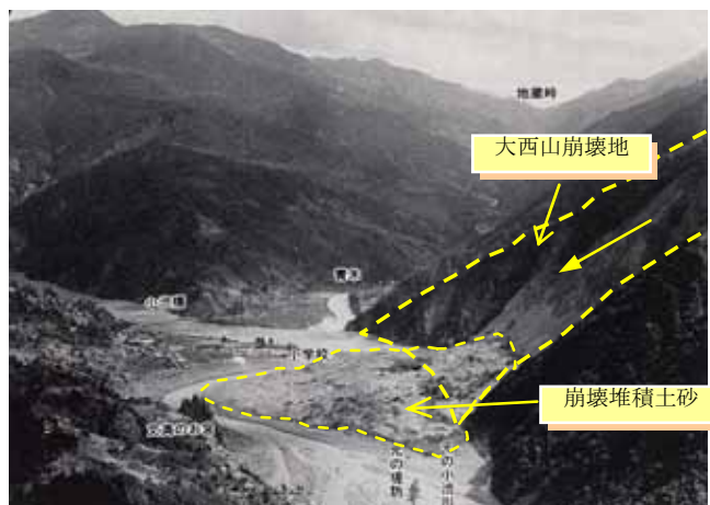
大鹿村大西山の大崩壊により、小洪川が一次土砂でせき止められた(昭和36年)
