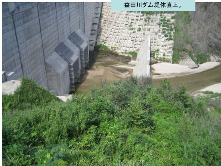
益田川ダム堤体直上。ダムの底面にゲートレスの水門が2門ある。ゲートの保護網が見える。上流にあるには仮締切(転流工)で今は流木防止に利用
