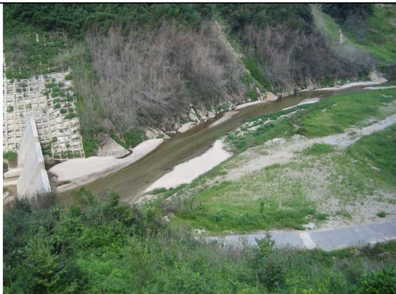
ダム上流側(砂の堆積が顕著、この時は大きな洪水は受けていなかった。景観的には大きな砂防堰堤の上流、その後の大きな洪水で砂はフラッシュされたと聞いた)
