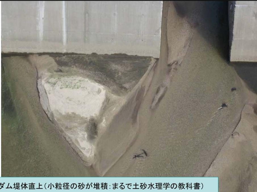
ダム堤体直上(小粒径の砂が堆積:まるで土砂水理学の教科書)
