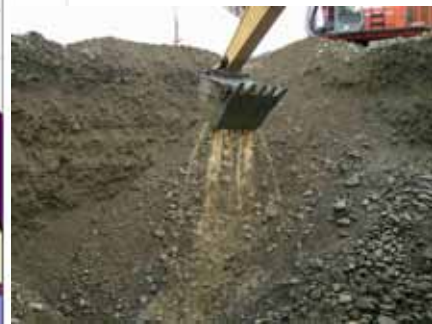
下流部の砂利採取状況
