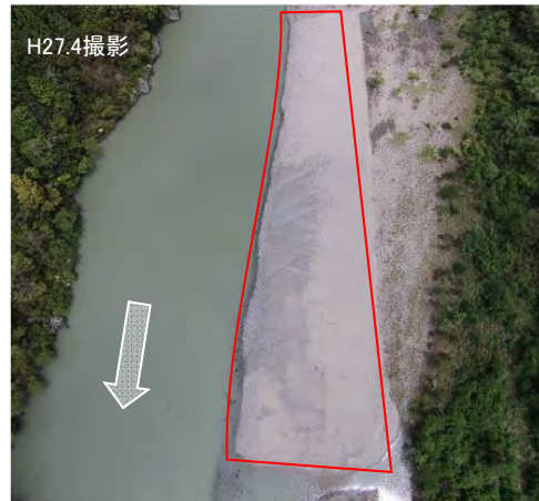
平成25年度実施 置土実験状況 ※平成27年4月洪水で一部流出
