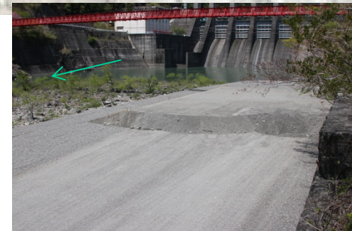
秋葉ダム下流置土設置状況(H24JP設置) 14
