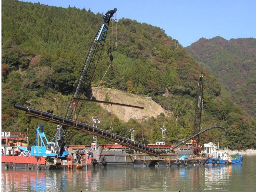
吸引管敷設状況
