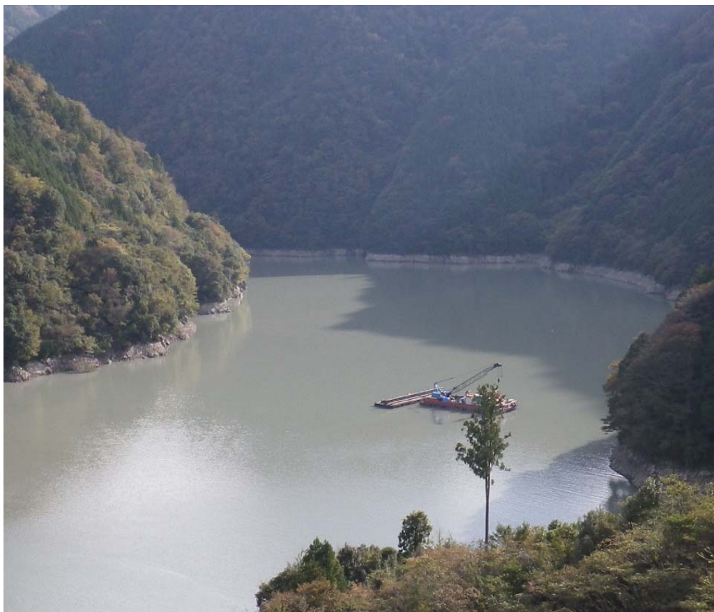
実験現場全景
