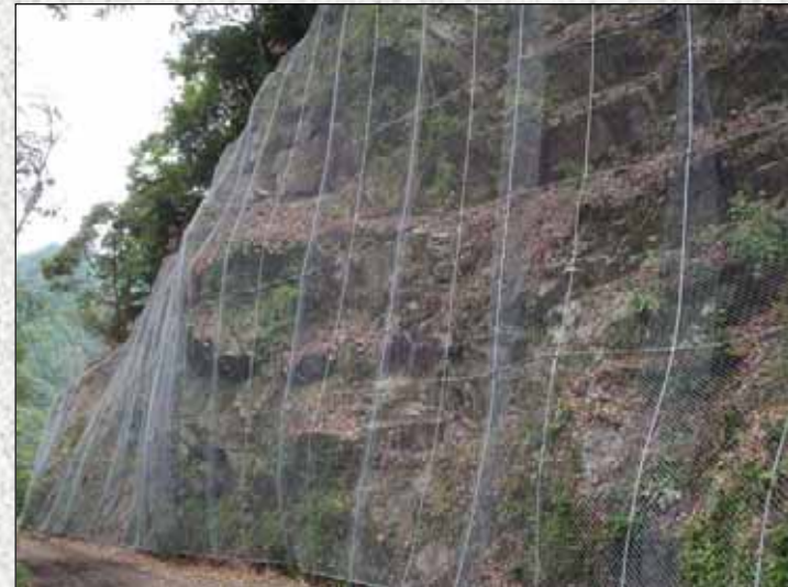
落石防止網工 施工完了
