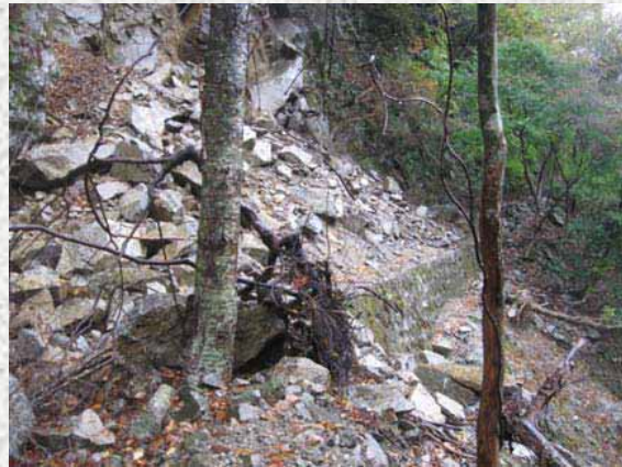
①調査用進入路
