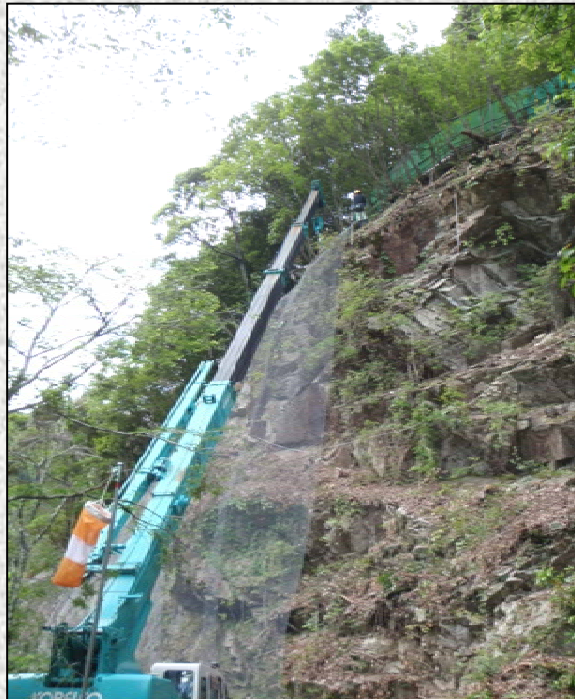
落石防止網工 施工状況(金網設置)
