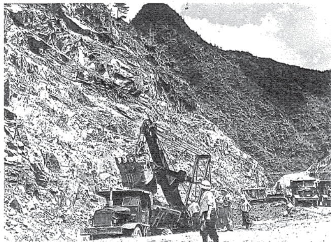
建設中の佐久間ダム。米国製大型重機がうなりを上げ、発破の爆音を山あいにも響かせた(電源開発＝Jパワー＝提供)
