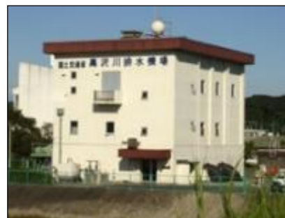
黒沢川排水機場
