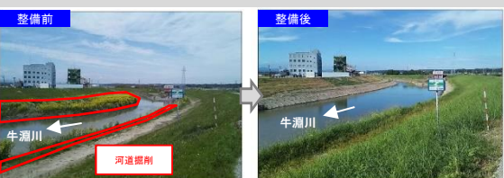
高水敷堆積土除去による流下能力の回復【菊川4.0k施工状況】
