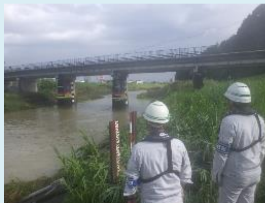
菊川 加茂水位観測所付近
