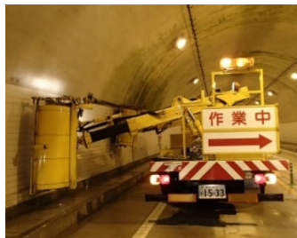
(トンネル内清掃)
