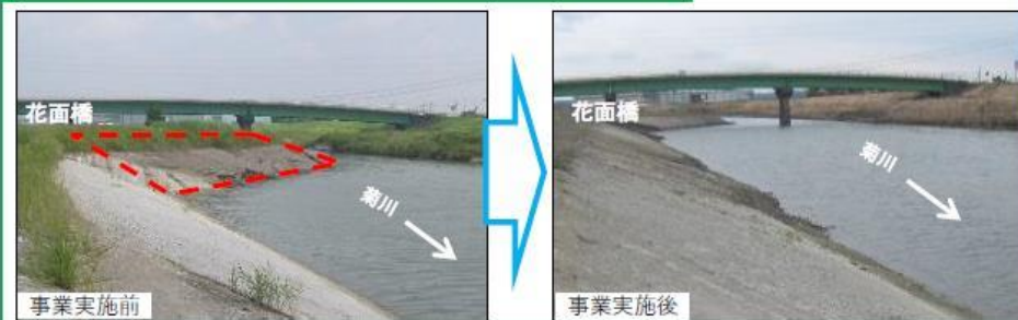
河床掘削による流下能力の向上【菊川4.0k施工状況】
