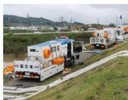
排水ポンプ車による 緊急排水作業
