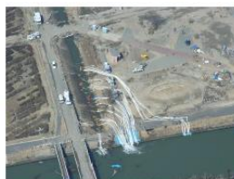
自治体所管施設の 被災状況調査
