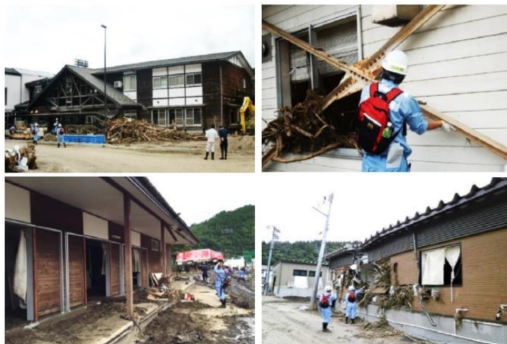
公共営繕施設の被災点検 (平成28年台風第10号)
