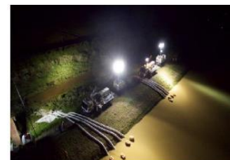
夜間排水作業を照らす照明車
