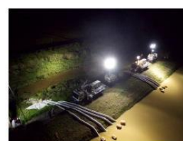
排水ポンプ車による 緊急排水
