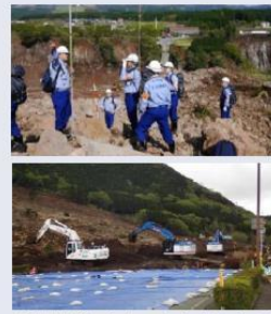
遠隔操作式バックホウによる土砂撤去作業
