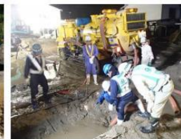
側溝清掃車による 堆積土砂の撤去
