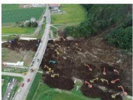
河道閉塞箇所において24時間体制で土砂撤去を実施
