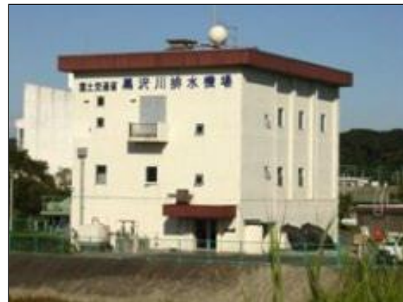
黒沢川排水機場
