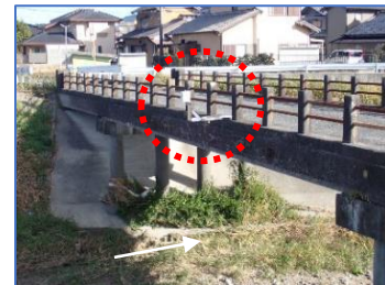
【施工事例】(二)垂木川〔掛川市下垂木〕
