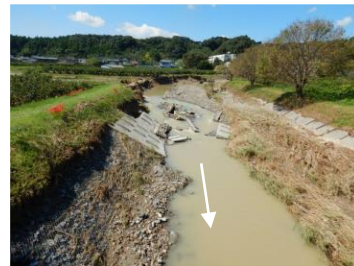
二級河川敷地川[磐田市敷地]
