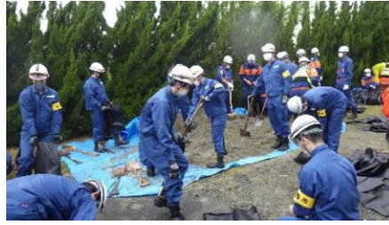
土のう作成訓練
