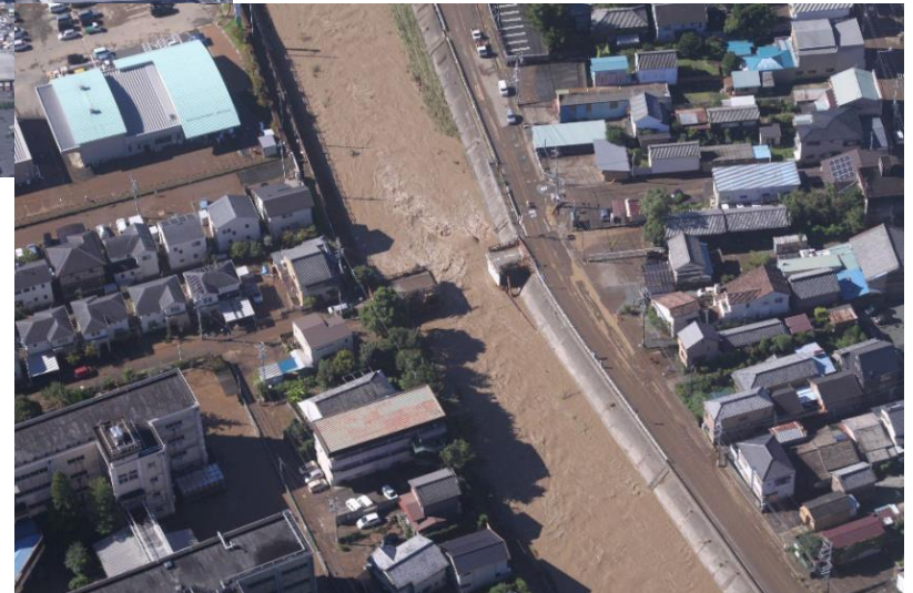
天竜区二俣町二俣地区 嘯月橋の流失
