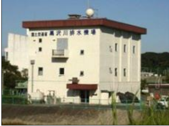
黒沢川排水機場
