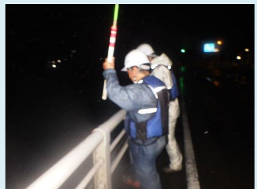
菊川 嶺田水位観測所付近
