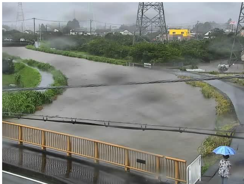
浜松市浜北区の矢矧橋水位観測所
