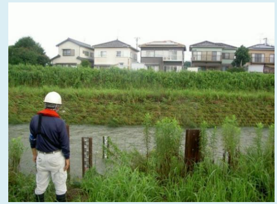
牛淵川 横地水位観測所付近
