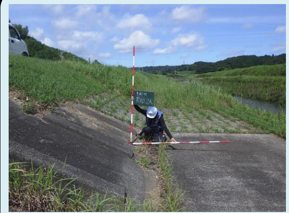
牛淵川 横地水位観測所付近
