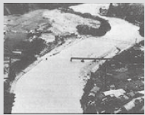
落橋したJR飯田線大千瀬鉄橋 出典:第8回天竜川流域委員会(H21.7.31)資料
