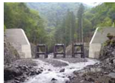
治山：溪間工（スリットダム）
