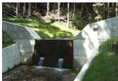
治山ダム工の設置
