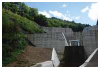
砂防堰堤の設置
