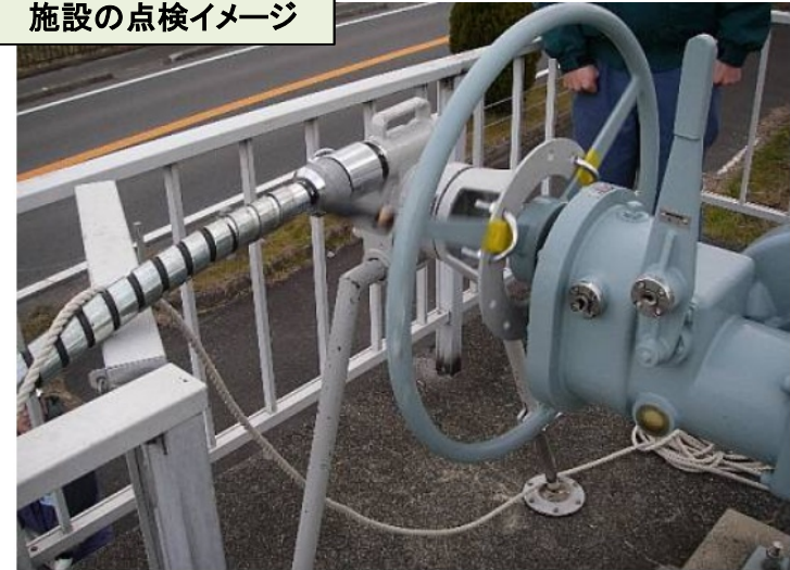
開閉装置と樋門の接続
